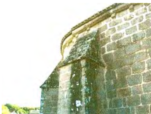
Extrémité est du mur nord
