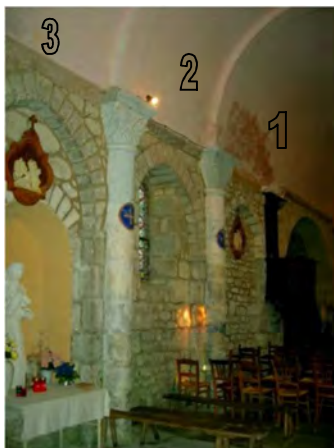
Vue, côté nord, des trois premières travées
