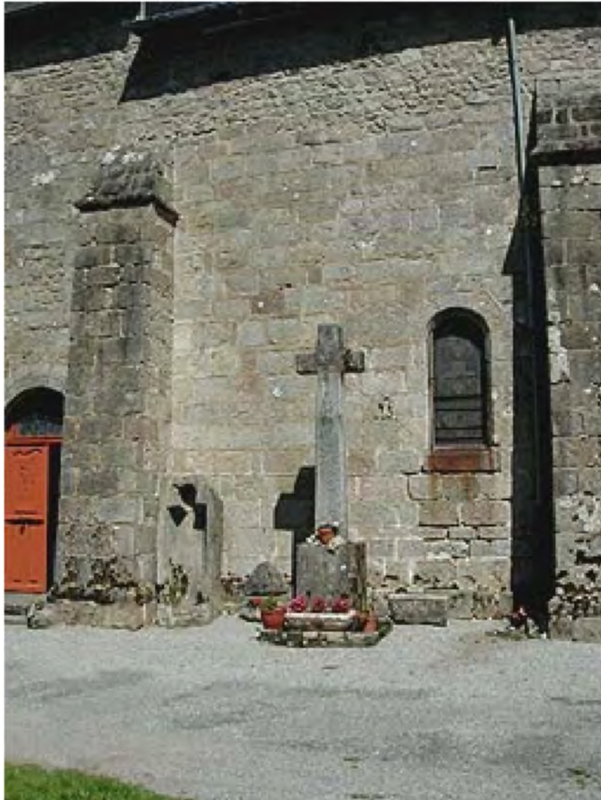
Extrémité ouest du mur sud
