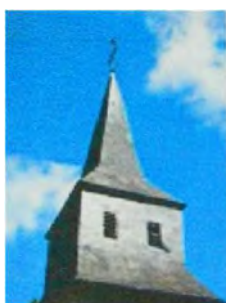
Clocher en charpente recouvert d'ardoises
