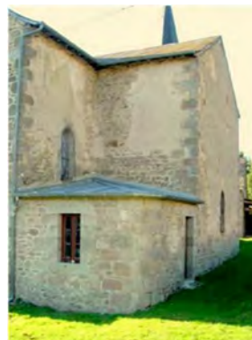
Mur nord et sacristie
