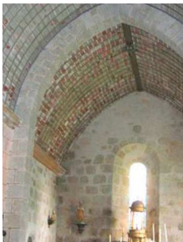
Voûte en briques et arc doubleau
